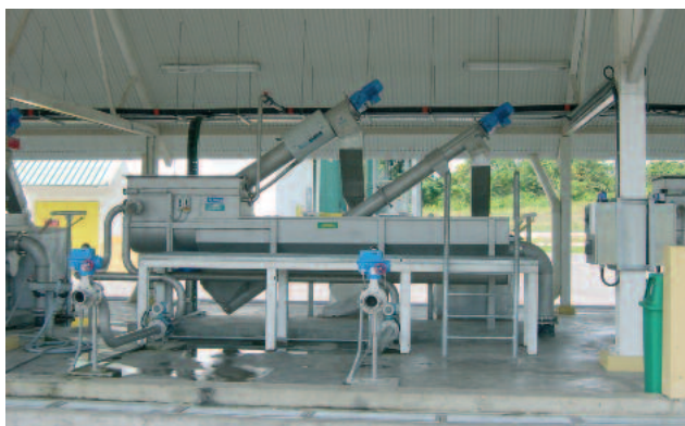
Установка ROTAMAT® с неаэрируемой песколовкой и интегрированным шнековым классификатором
