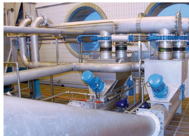
Система гидросмыва HUBER соединена с резервным моечным прессом HUBER WAP® SL
