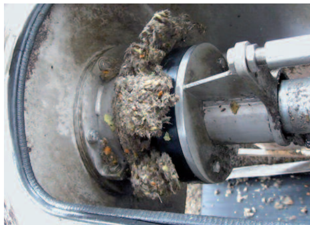
Descarga del residuo separado y compactado.
