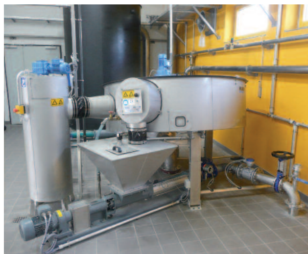
ROTAMAT® 转盘浓缩机RoS 2S 浓缩处理污泥 35 m 3 /h
