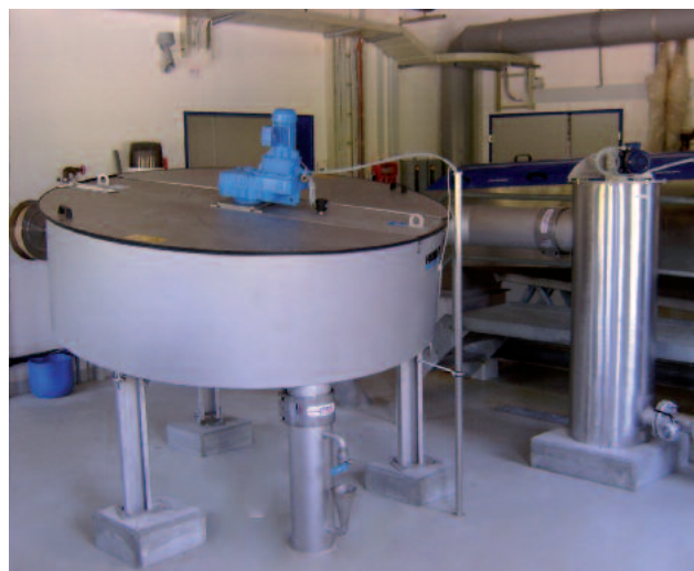
ROTAMAT® 转盘浓缩机 RoS 2S 规格，前面安装絮凝反应器
