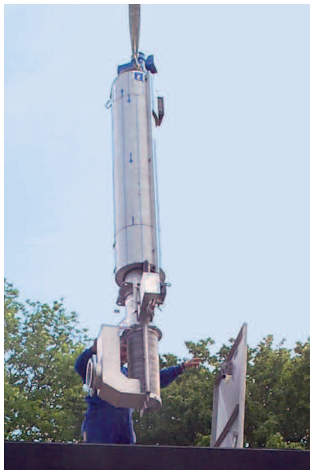
ROTAMAT® 垂直过滤装置RoK 4 被吊入泵站时的安装情况
