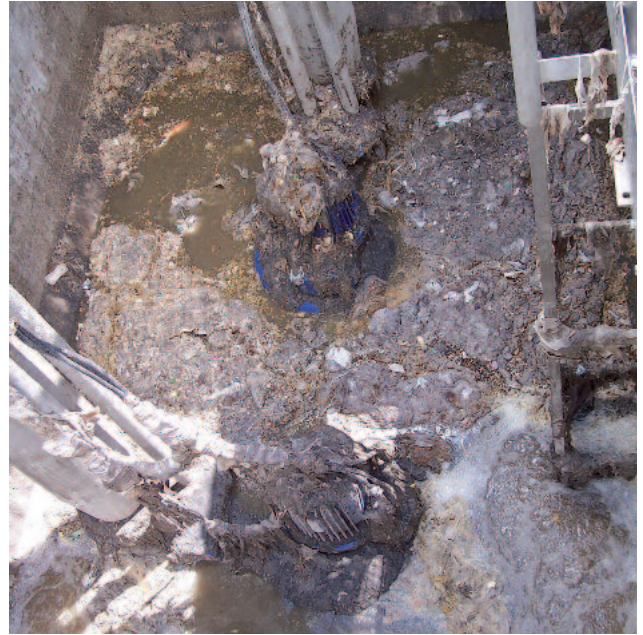
污水中的固体物质导致运输水泵出现堵塞
