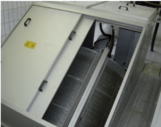
ROTAMAT® 过滤装置水渠安装，配置不锈钢盖板 - 装置规格 600 至3000
