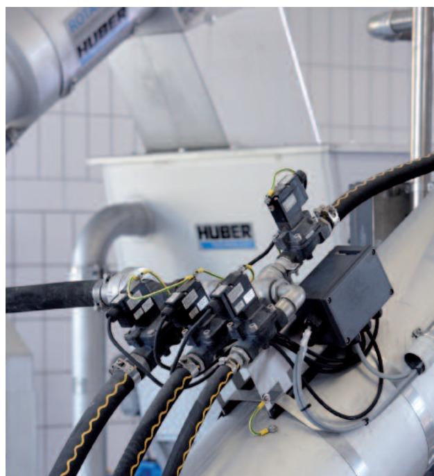
ROTAMAT® 过滤装置配置一体化栅渣冲洗系统
