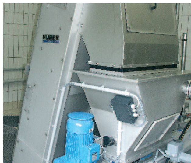
RakeMax® 后视图, 后续栅渣冲洗压榨机 (WAP/SL)
