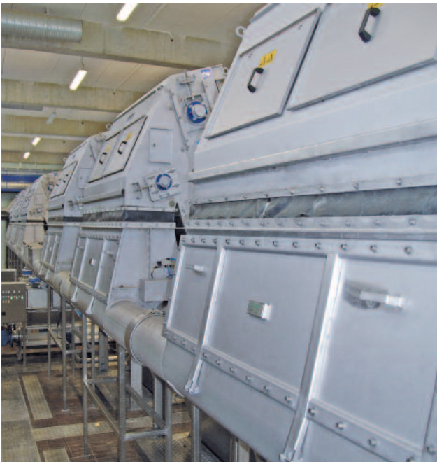
EscaMax® 背面, 出渣口配置栅渣压榨机 WAP
