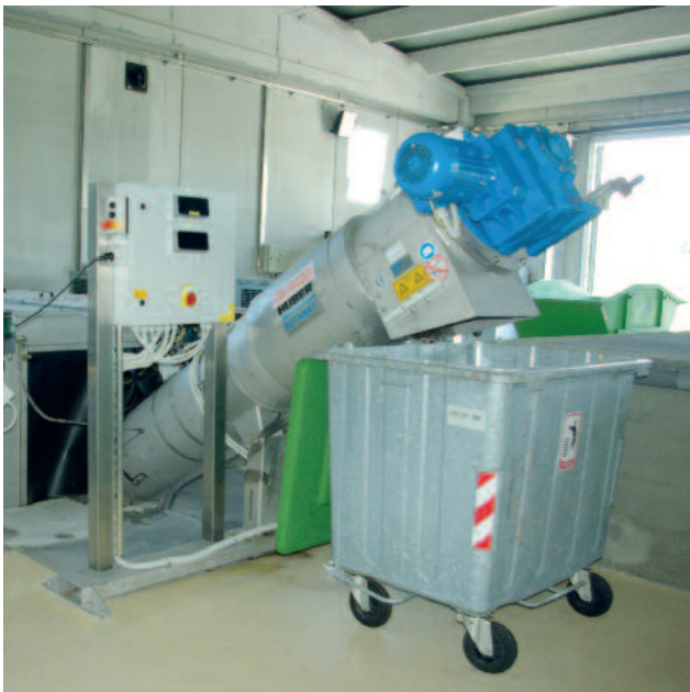
Abwassersiebung Lederindustrie Österreich : HUBER Siebanlage ROTAMAT® Ro2
