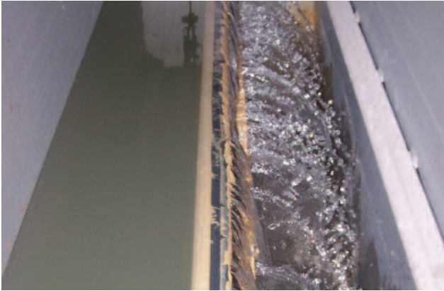
HUBER Druckentspannungsflotation: Ablauf gereinigtes und feststofffreies Abwasser
