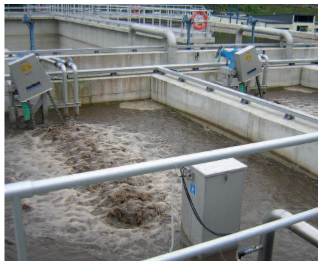
HUBER Membranfiltration VRM®: im Filtrationsbecken mit Feststoffgehalten bis 12% TR
