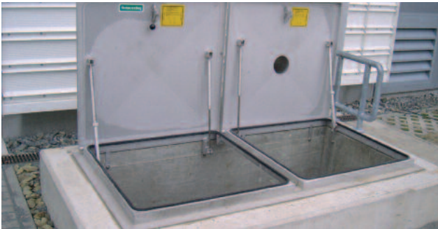
Egyedi méretű aknafedelek, kétrészes, szétszerelhető középbordával
