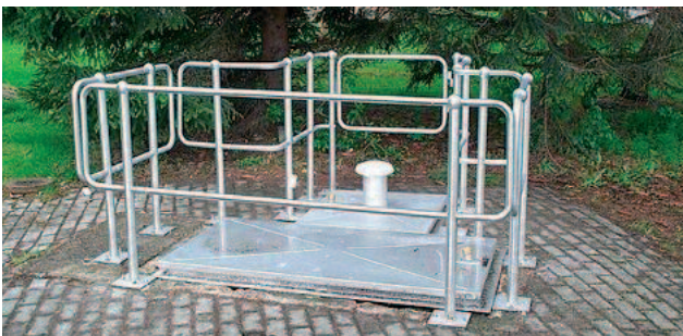
Aknafedél lépcsős lejárathoz, körbefutó korláttal és korlátajtóval
