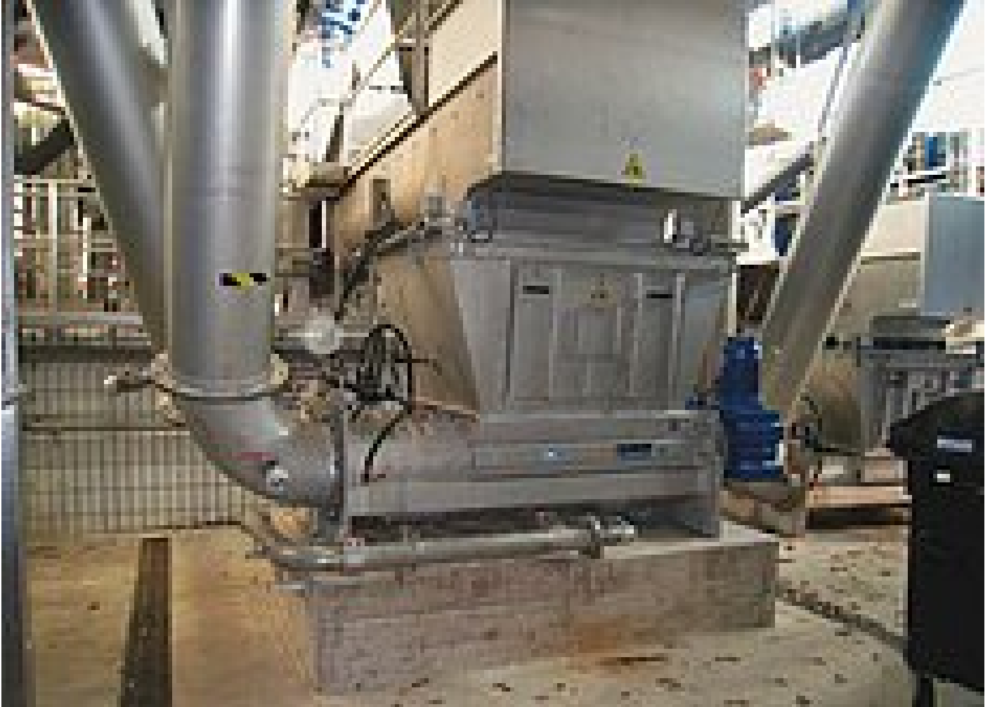
HUBER Prensa de lavado WAP 2x8 con una capacidad de rendimiento de 16 m³/h
